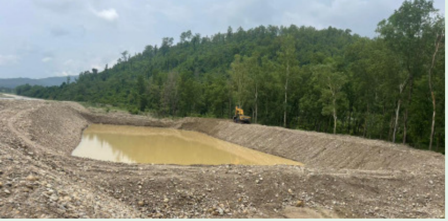
निर्माणाधिन संरक्षण पोखरी, सिन्धुली
