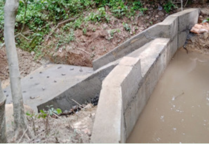
तस्वीर: ३ चेकड्याम निर्माण तथा संरक्षण पोखरी, जलकन्या सामुदायिक वन केरावारी, मोरङ
